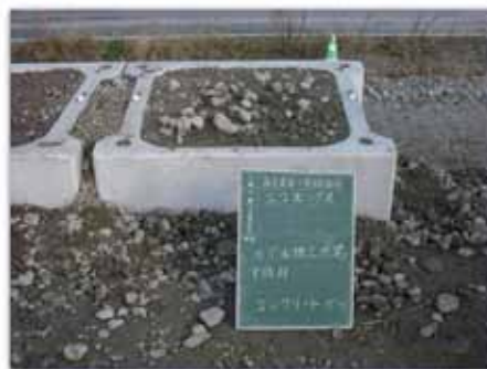
コンクリートがら
