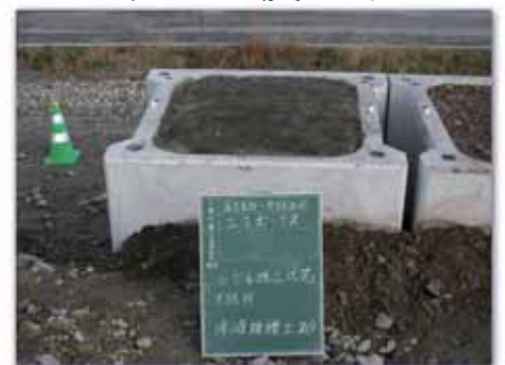
津波堆積土砂
