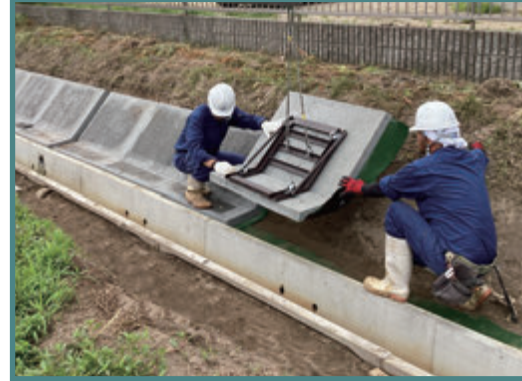
新技術 (プレキャストコンクリートブロック)
