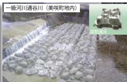
魚巢機能と根固め機能を併せ持った複合型根固めブロック
