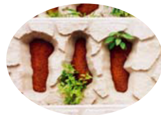
中詰材(土砂・土のう)
