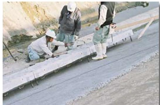
大型張りブロック据付状況 らくピタ調整後
