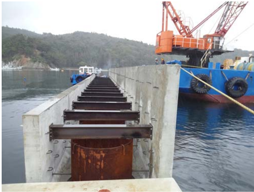
ハーバーキャップ設置状況です。製品の通りも綺麗に仕上がりました。
