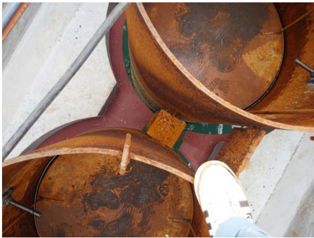
ハーバーキャップを固定し、鋼管矢板との隙間を塞ぐように底型枠の位置を調整します。
