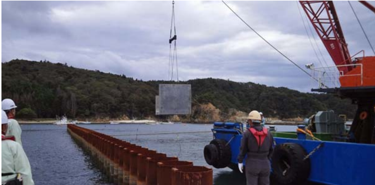
ハーバーキャップによる防波堤上部工構築
