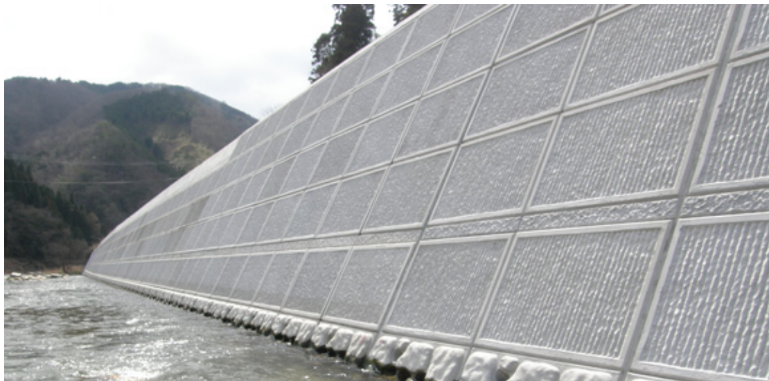
大型ブロック積み擁壁 エコボックス 施工事例
