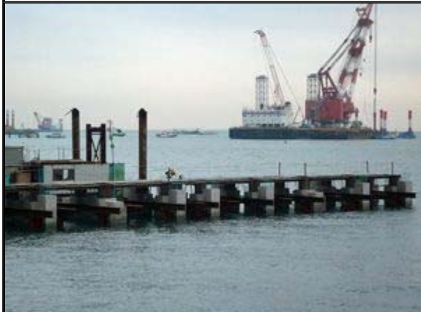
8. 栈橋ブロック据付完了状況
