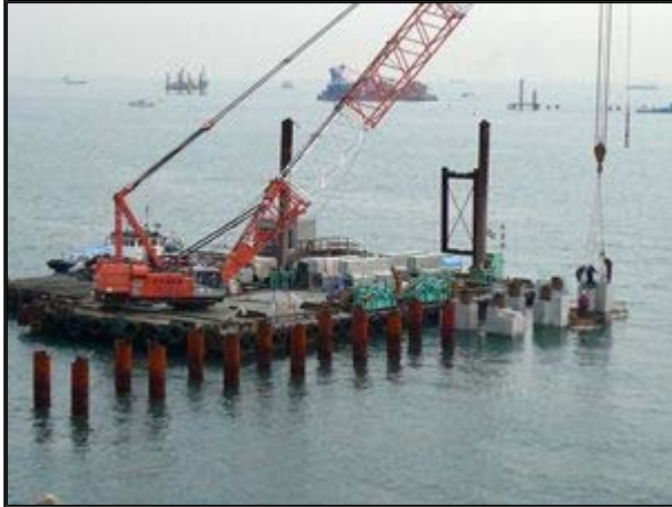
6. クレーン付台船配置状況
