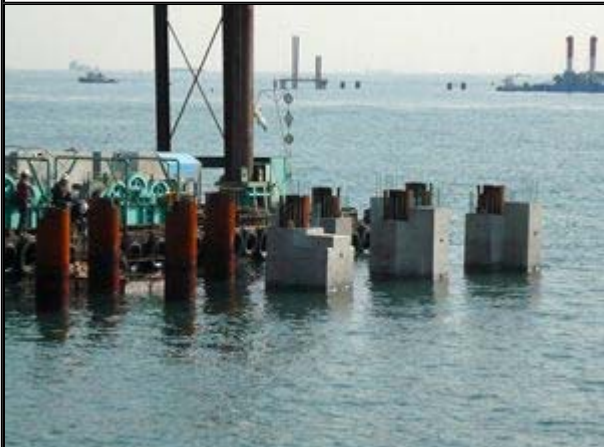
7. 栈橋ブロック据付中
