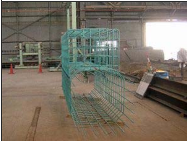
3. 工場製作状況【エポキシ鉄筋】
