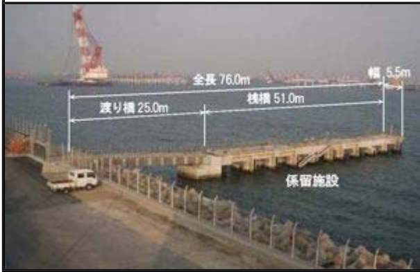
1. 係留施設写真(施工完了)
