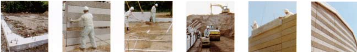
基礎整地 パネル設置 ストリップ取付 土のまき出し・転圧 天端処理 完了
