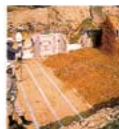
土のまき出し
